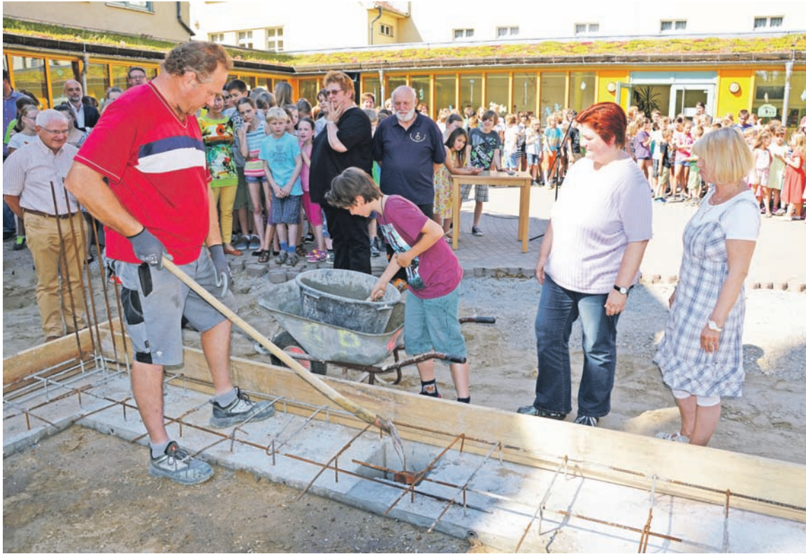
Schülersprecher Till (Mitte) füllt gemeinsam mit Juliane Henning und Marion Gunter (re.) das vorgefertigte Loch mitsamt der Kupferkartusche mit Mörtel auf.
