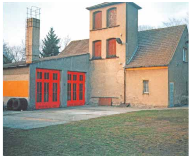
Im Dezember 1974 konnte das neue Gerätehaus wieder in Betrieb genommen werden. Die Kameraden haben ganze Arbeit geleistet. Foto: privat
