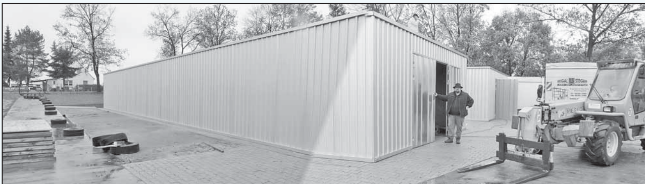
Lars Hallman hat zwei neue Hallen angebaut
