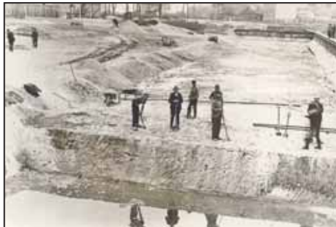
Foto aus dem Archiv von Hans Keller: Bauarbeiten im Frühjahr 1926
