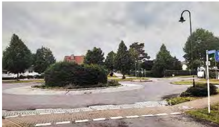
Ansicht Kreisverkehr im Altzustand
