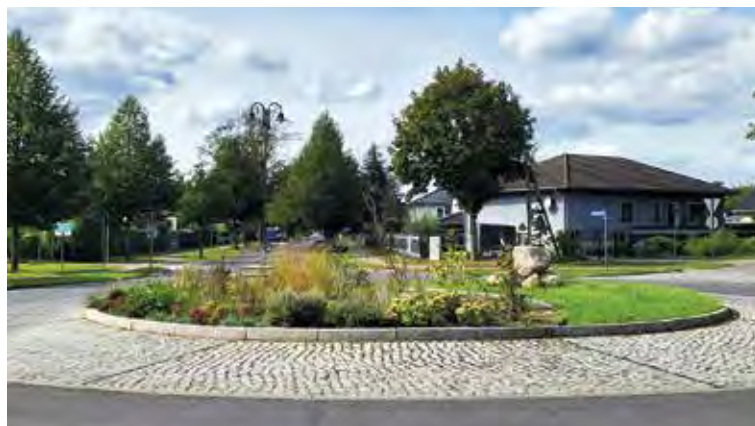
Ansicht Kreisverkehr nach der Neupflanzung
