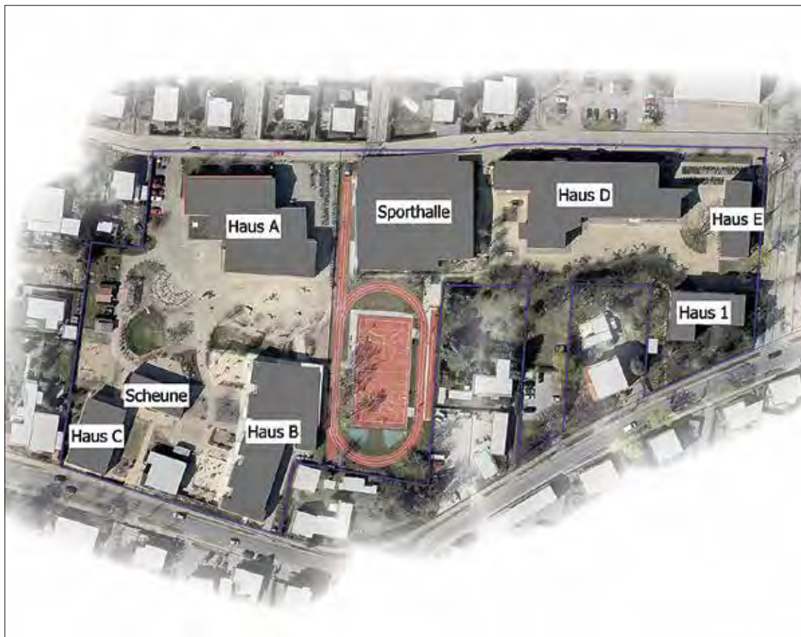
Grundschulcampus – Übersicht Gelände
