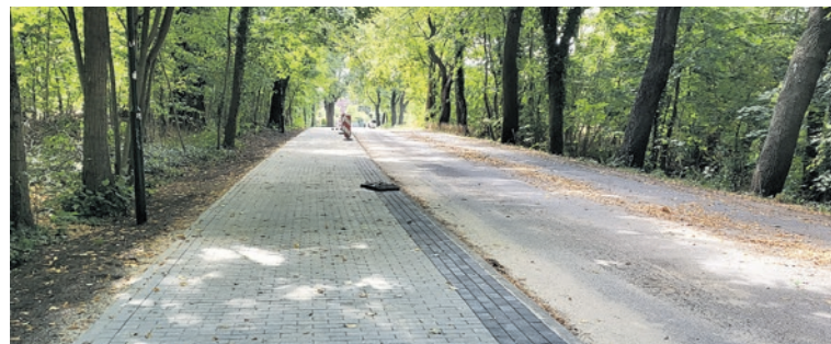
Die fertiggestellte Anlage kurz vor der Freigabe
