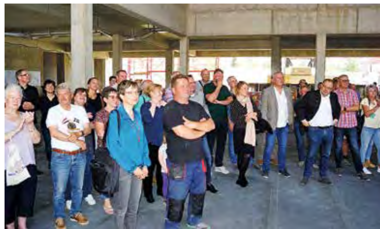
Die rund 80 Besucher des Richtfestes verfolgten im Rohbau vom Gebäudeteil 2 die Ansprachen des Bürgermeisters, des Oberschulleiters, des Architekten und des Vorsitzenden der Gemeindevertretung.
