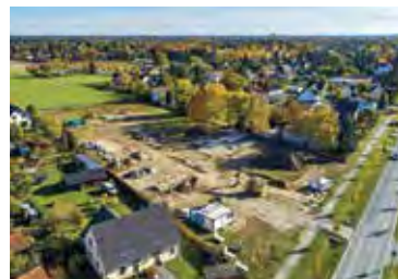
Blick auf die Baustelle der Firma HELMA-Haus.
