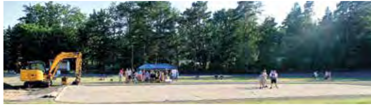
Noch nicht ganz fertig – aber gut zu erkennen: das 18 Meter mal 36 Meter große Terrain, auf dem künftig die Mitglieder des Inline-Skaterhockey-Vereins auch im Freien trainieren können.
