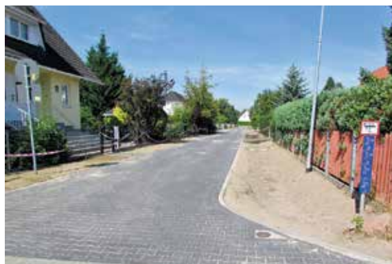
Kornblumenweg in Betonpflastersteinen
