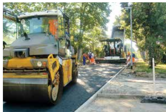
Herstellung einer Asphaltdecke – Inselstraße im Q6
