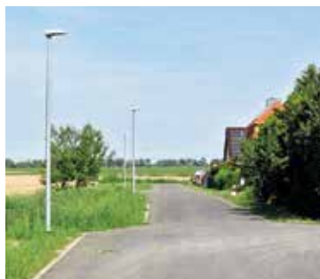
Senefelder Straße (Fredersdorf-Nord) mit Asphaltdecke und moderner LED-Straßenbeleuchtung
