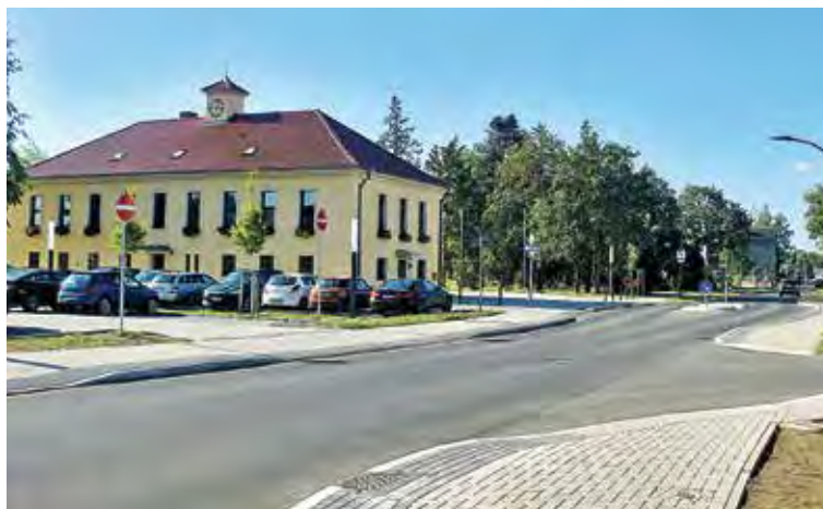
Neu ausgebaute Lindenallee mit beidseitiger Geh- und Radwegführung
