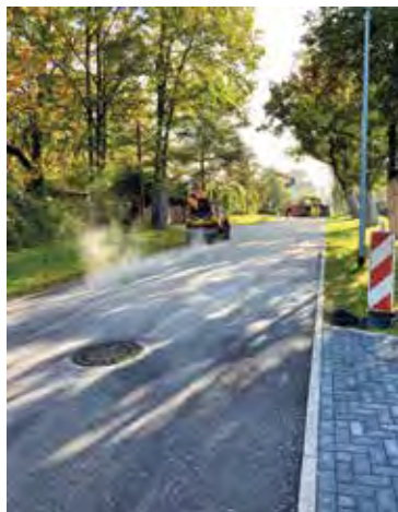
Herstellung Asphaltdeckschicht im Q6, Inselstraße 2020
