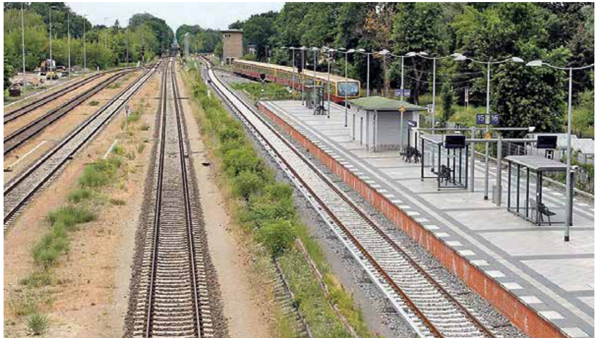
Blick von der Fredersdorfer S-Bahnbrücke auf die erneuerten Gleisanlagen.
