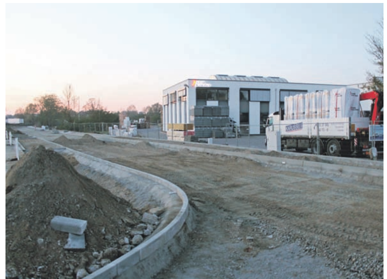
Kurz vor der Fertigstellung: Die Gemeinde baut die Erschließungsstraße für das Gewerbegebiet an der Fredersdorfer Straße.
