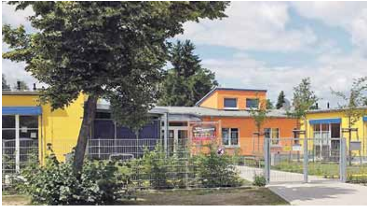
Leuchtend gelb und intensiv orange: In diesem modernen Flachbau im Verbindungsweg ist die Kita des Humanistischen Verbandes beheimatet.
