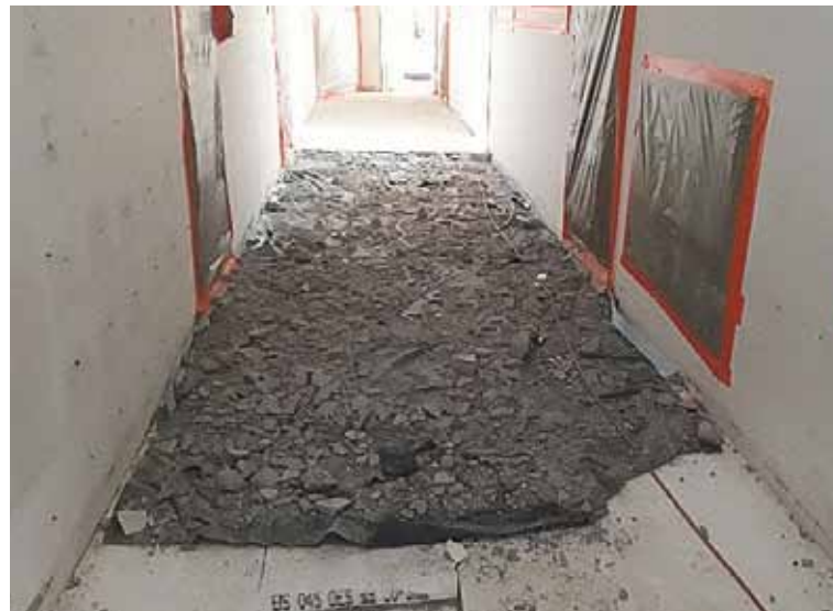
Folge eines Wasserschadens: Knapp 160 Quadratmeter Fußboden in der Kita Verbindungsweg musste erneuert werden. Foto: e.b.
