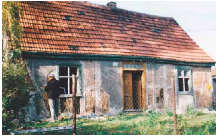
Wurde 1999 abgerissen: Das damals älteste Haus in Fredersdorf konnte trotz vieler Mühen nicht gerettet werden.
