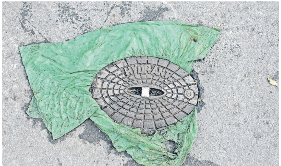
So sehen sie aus, die Unterflurhydranten, die manche für Gullys halten: Eingefügte Folien sollen das Einfrieren der Deckel verhindern.
