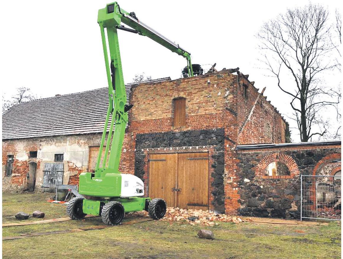
Mit einer Hebebühne wird das nachträglich aufgesetzte Dach des Pächterhauses Stein für Stein abgetragen. Dann soll ein Notdach aufgesetzt werden -eine umfassende Sanierung muss trotzdem erfolgen.
