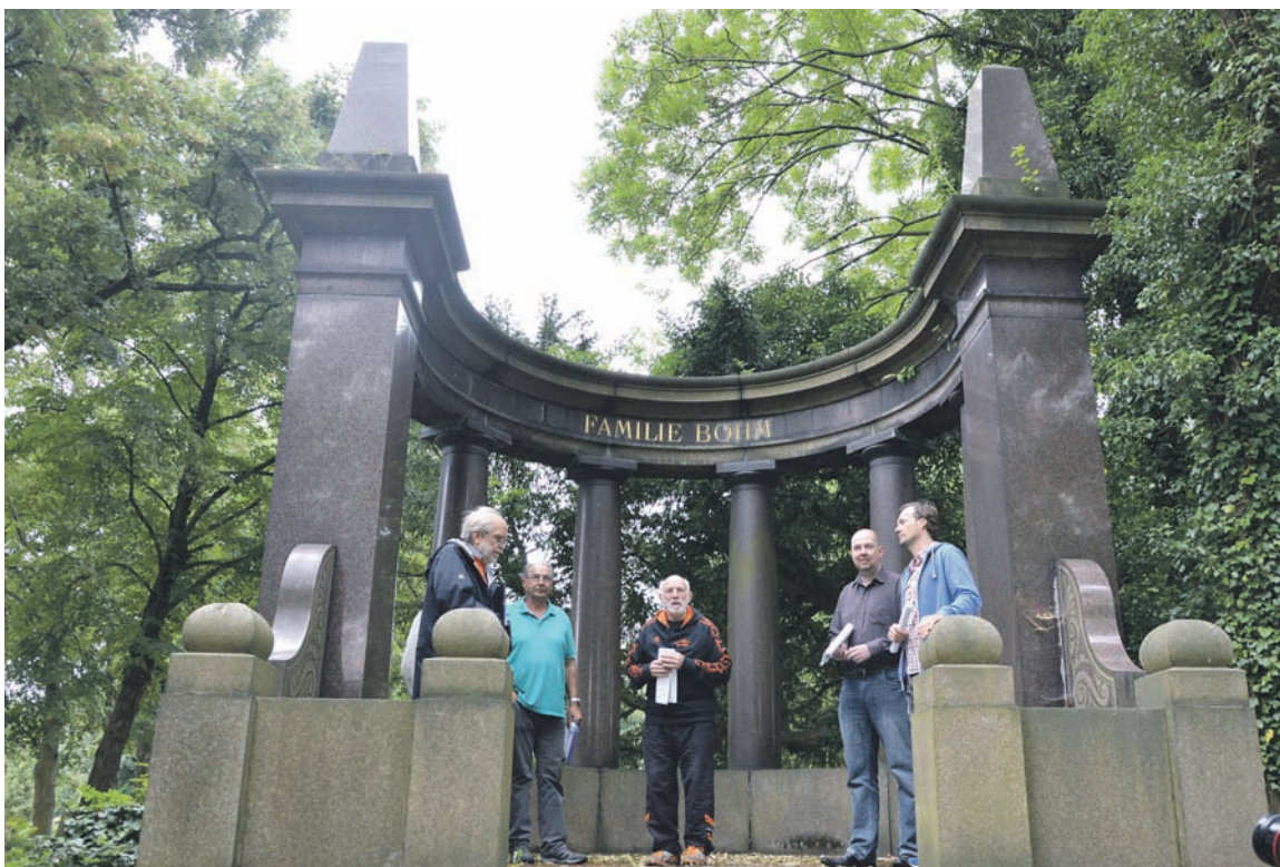
Klaus Häcker (Mitte) engagiert sich mittlerweile seit elf Jahren für den Erhalt des Bohmgrabs und freut sich, dass die Sanierung nun endlich beginnen kann. Foto: lh
