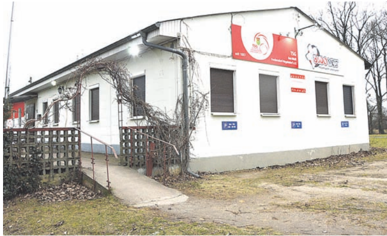
Das Vereinsheim in Vogelsdorf stammt noch aus den 60er Jahren. Es fehlt an Platz und es besteht Sanierungsbedarf.
